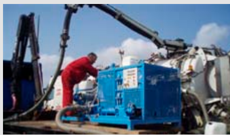
Tømning af slamsugeren via DOD til AVC-slamafvandingscontaineren.
